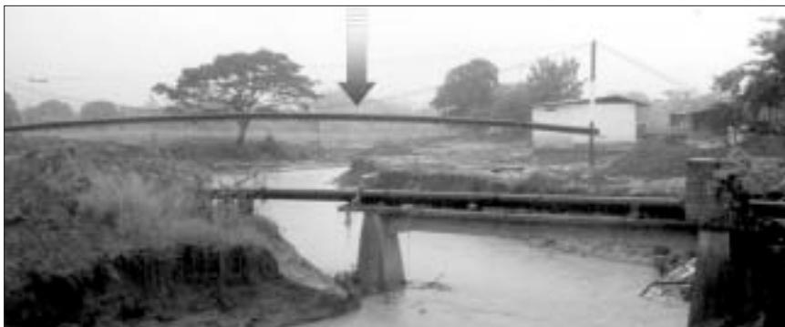
Medida de mitigación, paso elevado de mayor seguridad. Fenómeno El Niño, Ecuador 1998
