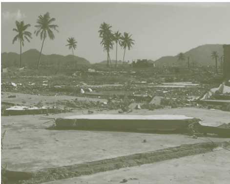
De estas casas en Banda Aceh sólo quedó el solar
